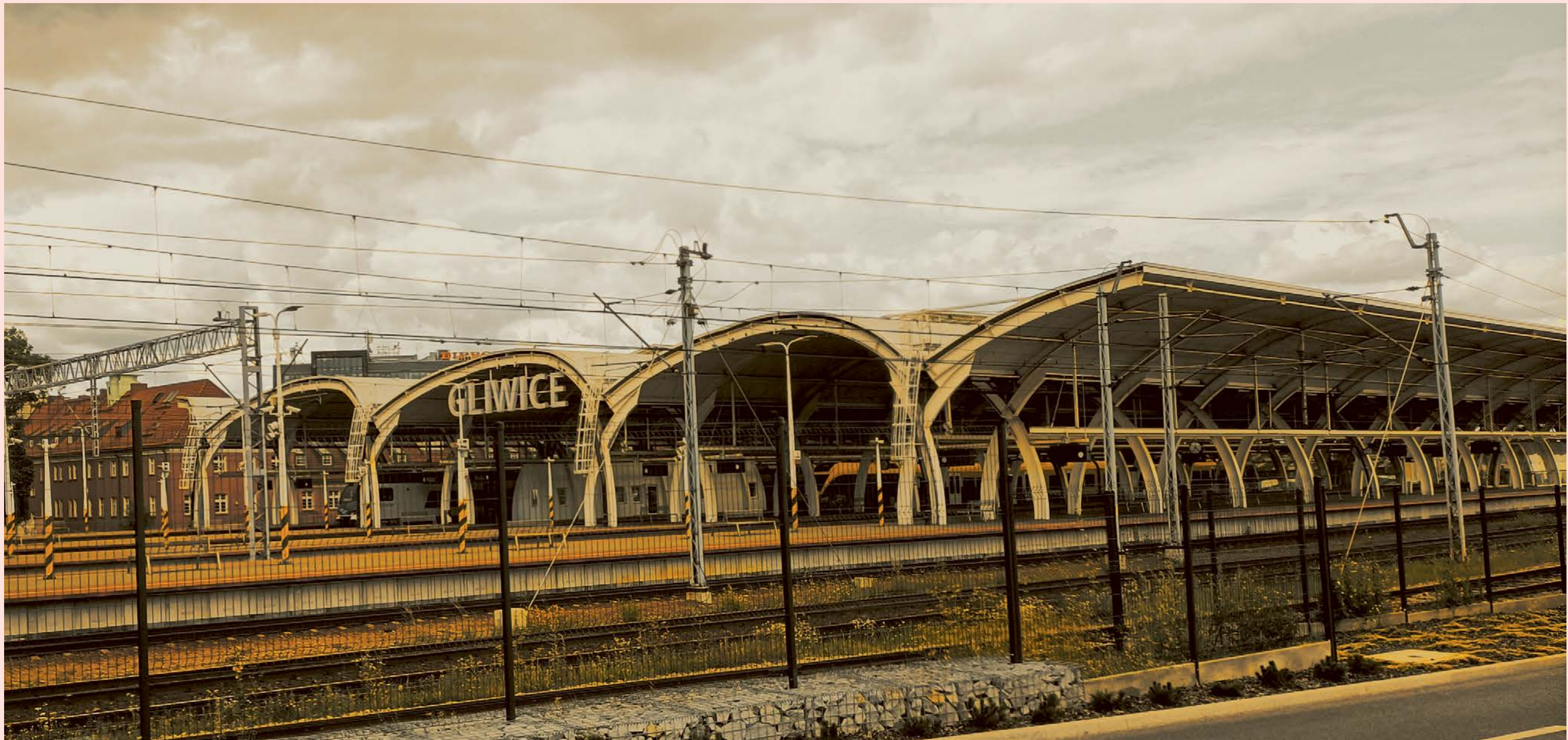
Hauptbahnhof Gliwice / Dworzec główny w Gliwicach Martin Erich Vogiel
